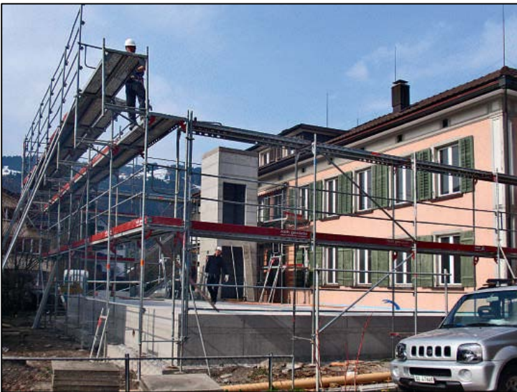
Abbildung 10: Bau der Landarztpraxis in Ebnat-Kappel (ROHNER, PrimaryCare 2012)
