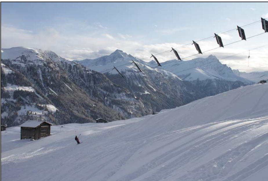
Abbildung 13: Skilift Tenna mit Solarpanels im Safiental (GST 2010).
