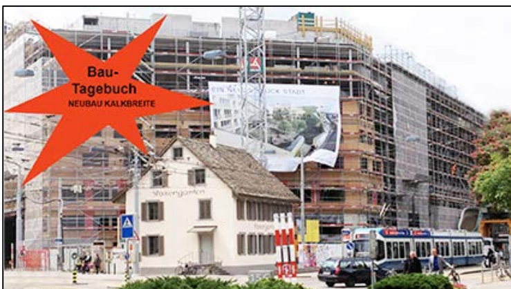
Abbildung 11: Bau der Wohnbaugenossenschaft Kalkbreite (KALKBREITE 2013).
